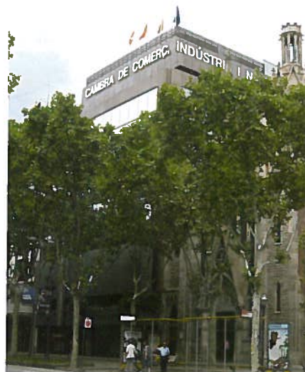
LA SEDE DE SECOT BCN ESTÁ EN ESTE EDIFICIO.
